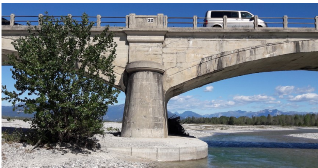
Figura 26 – Vista da valle della pila 32 (numerazione da Spilimbergo a Dignano) – sopralluogo settembre 2018
