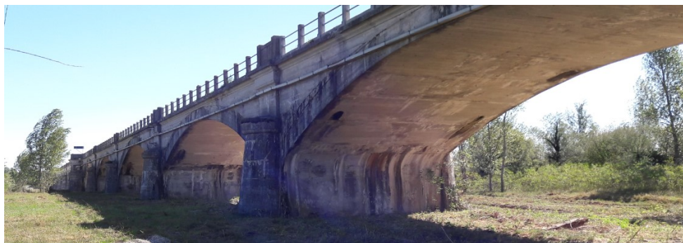
Figura 6 – Vista da monte del ponte SR464, golena destra, lato Spilimbergo (sopralluogo settembre 2018)
