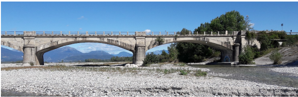
Figura 4 – Vista da valle della spalla sinistra, lato Dignano (sopralluogo settembre 2018)
