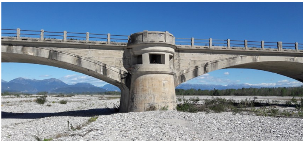
Figura 5 – Pila in alveo attivo, vista da valle (sopralluogo settembre 2018)
